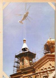
Установка купола на Ильинский храм (фото 1990 года)
